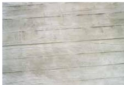
Дополнительное создание структуры дощатой опалубки на отремонтированных участках
