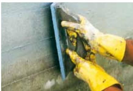
Шпатлевка с начесом, наносимая губкой или шпателем из жесткой резины, сохраняется структура дощатой опалубки.
