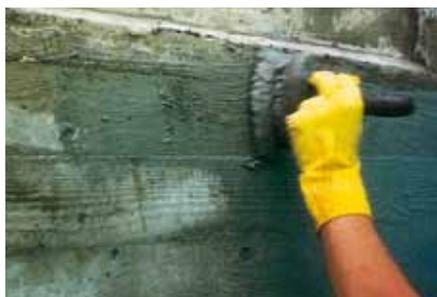
Обмазка усадочных раковин, производимая кистью, сохраняется грубая структура дощатой опалубки
